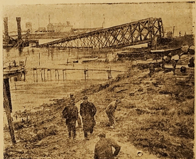
Oben: In dem zwischen den Inseln Seeland und Masned gelegenen Masned-Sund hat sich ein schwerer Unfall ereignet. Dort fuhr ein englischer Tankdampfer gegen eine Brücke, die bei dem Zusammenstoss einstürzte. Der Warenverkehr zwischen Deutschland und Dänemark ist dadurch stark behindert.
