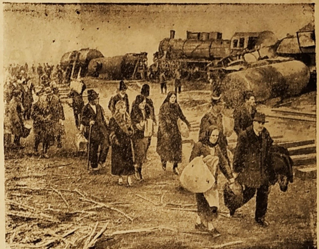
In der Nähe der rumänischen Hauptstadt Bukarest stießen im Nebel infolge falscher Weichenstellung zwei Petroleumzüge zusammen. Obwohl das Petroleum sofort in Flammen aufging, kamen Menschen nicht zu Schaden.
